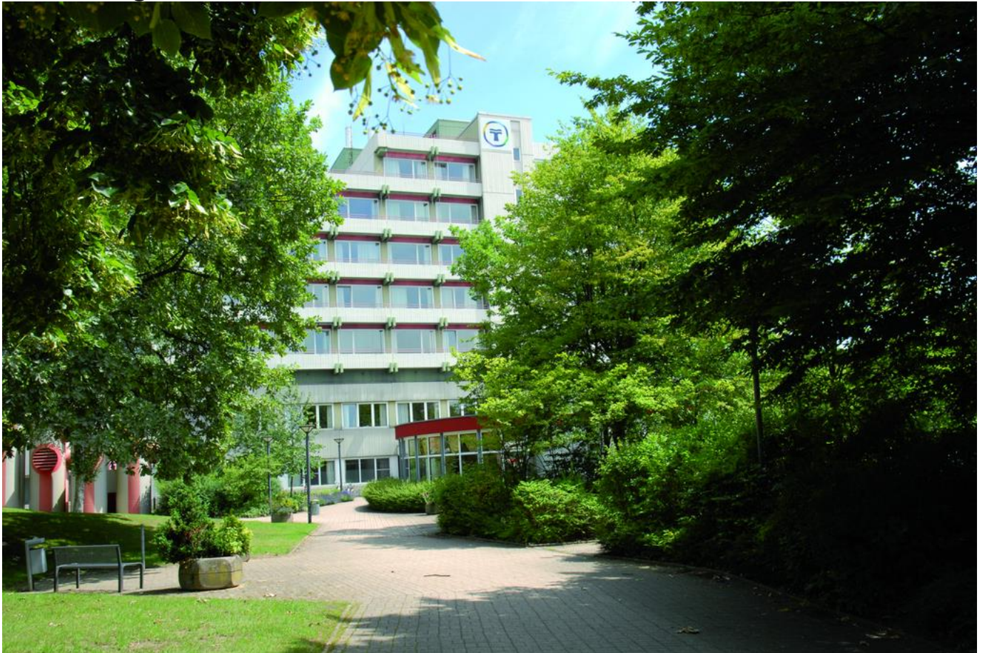
Abbildung: St. Josef-Krankenhaus Hamm-Bockum
